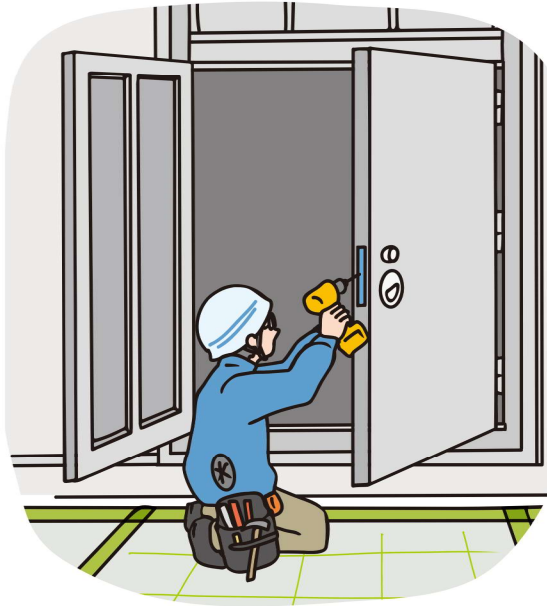
ドア取り付け(金物工)
